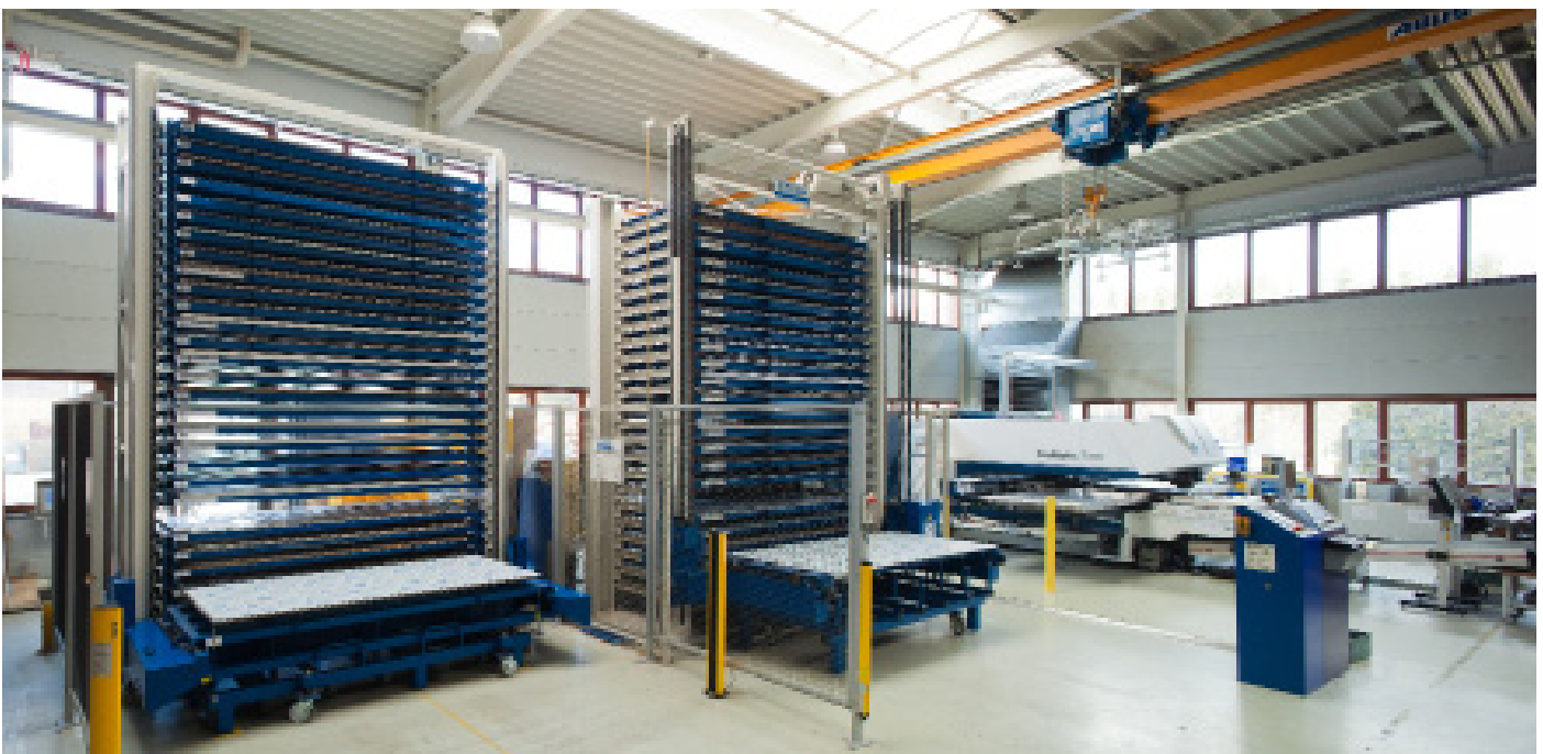
Die STOPA TOWER Blechlager beanspruchen wenig Platz und sind auf kurzen Wegen an die Laserschneid- und Stanzanlage von SCHAEFER angebunden
