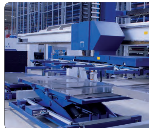
Zwei Scherenhubtische beliefern den SheetMaster mit Blechen aus dem Lager.
