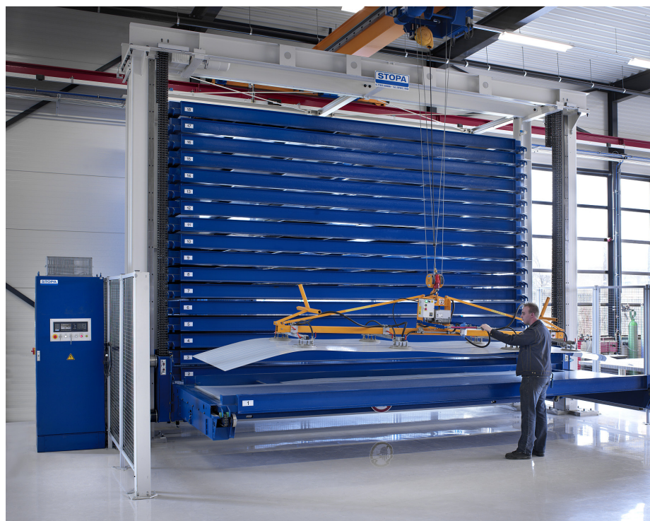
Das Handling der Bleche ist durch den Einsatz der Blechlagertürme ergonomischer, sicherer, schneller und damit wirtschaftlicher geworden.
