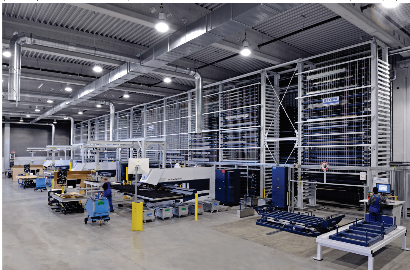
Le fabricant de panneaux de métal déployé et de tôles perforées MEVACO utilise son magasin automatique STOPA COMPACT comme base d'une qualité de livraison élevée
