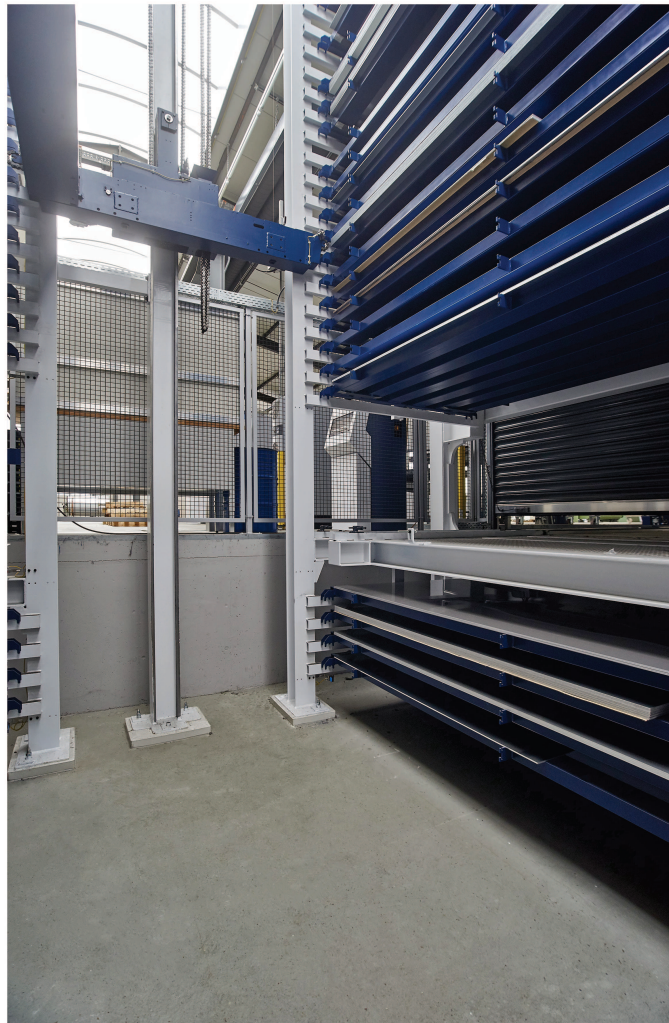
Die Idee, das Lager in eine Grube zustellen, erwies sich als wirtschaftlichste Lösung
